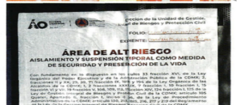
Los sellos de la plaza, ubicada en Álvaro Obregón, hacen referencia a deficiencias en materia de Protección Civil.
