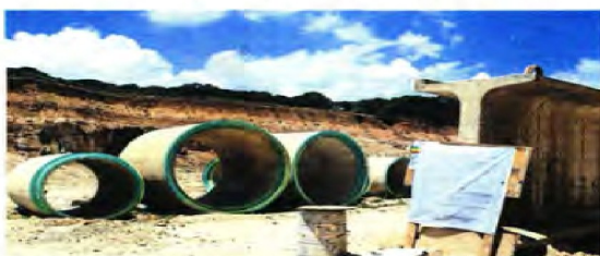
En una de las zonas que atraviesa el bosque hay un aviso que señala que la empresa ICA dejó de ser contratista del proyecto.
