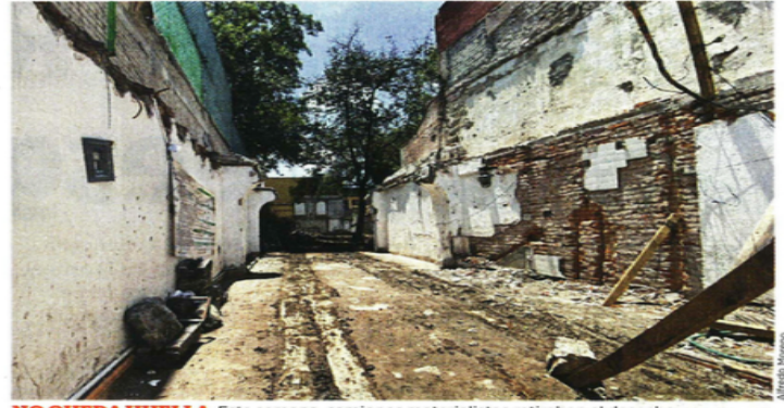
NO QUEDA HUELLA. Esta semana, camiones materialistas retiraban el desecho que generó la demolición en Calle Reyna.
