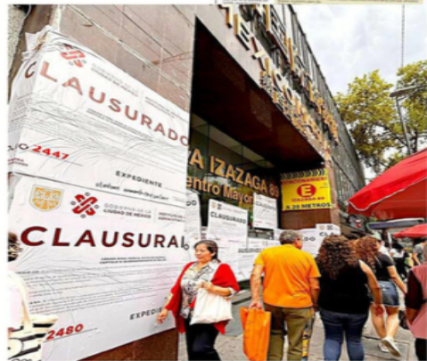
El Instituto de Verificación Administrativa (Invea) clausuró ayer la plaza "México Mart" de 16 pisos.
